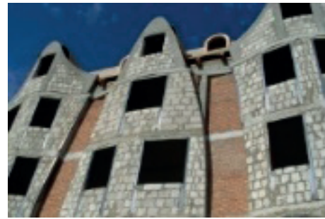
Rys. 22. Modernizowane zabytkowe domy gdańskiej starówki (23)
