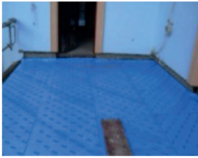
Rys. 21. Izolacja tarasu w pałacu pod Poznaniem (23)
