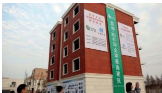
Rys. 34. Czterokondygnacyjny budynek w technologii druku 3D Szanghaj – Chiny (31)
