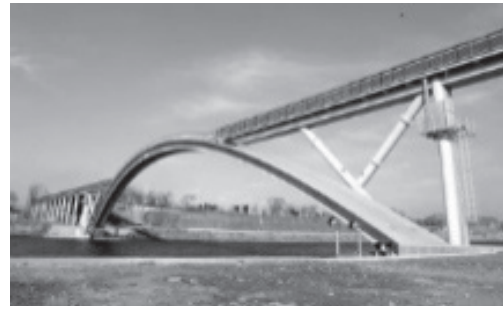
Rys. 28. Kładka Sunyonu w Seulu [łuk 130 m, 2002 r.] z betonu samozagęszczonego,
