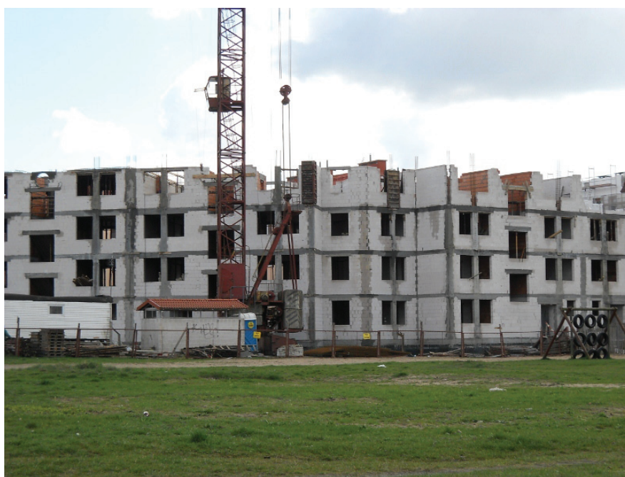
Rys. 7. Bloki mieszkalne z betonu komórkowego w trakcie budowy (4)
