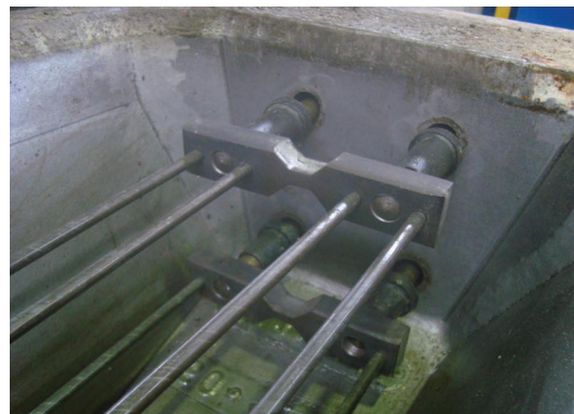
Rys. 3. Płytki kotwiące oraz zamocowanie płytek w formie przed jej zabetonowaniem stosowane w zakładach TrackTec
