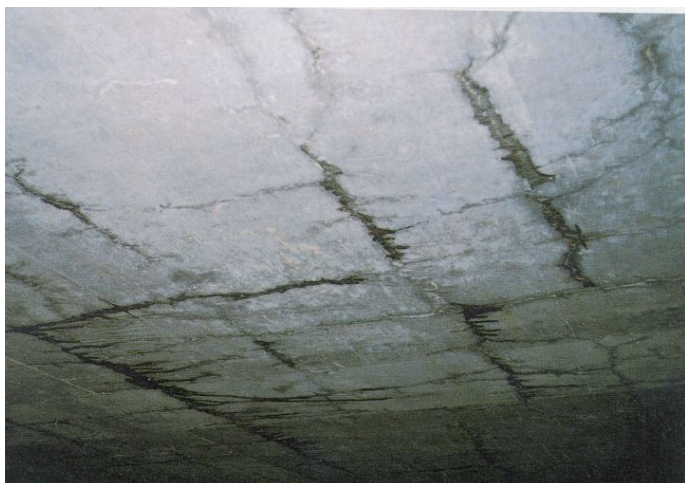
Rys. 1 Naprawa spękań na stropie
