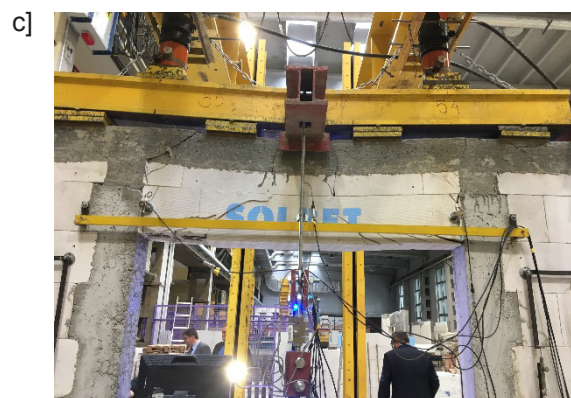
Rys. 22. Uszkodzenia ścian pełnych: a) M2SO-Z2-1, b) M2SO-Z2-1, c) M2SO-Z2-2.
