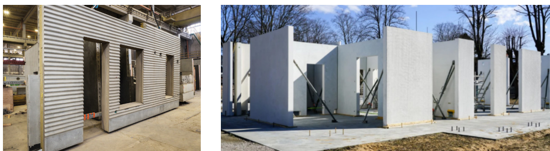
Rys. 3. Prefabrykowana ściana elewacji [po lewej], montaż prefabrykatów na budowie [po prawej].
