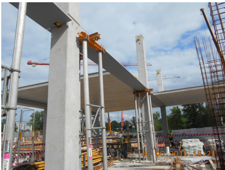
Rys. 12. Plac budowy kompleksu Business Garden Wrocław w 2015 r.
