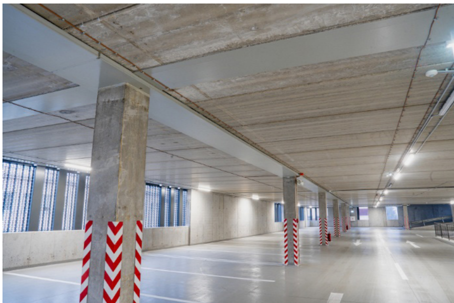
Rys. 1. Przykład konstrukcji stropu typu slim floor.
