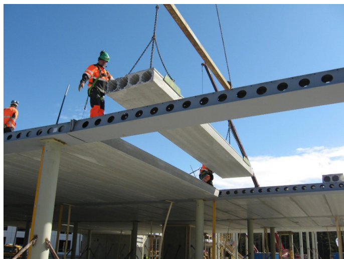
Rys. 6. Montaż systemu DELTABEAM®.
