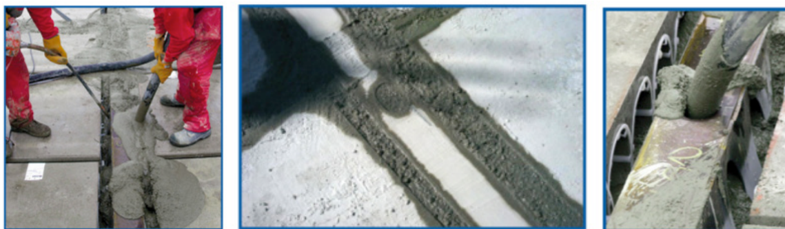
Rys. 7. Betonowanie systemu DELTABEAM®.
