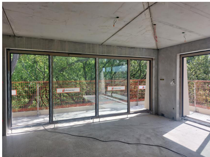
Rys. 5. Montaż przeszkleń o dużej powierzchni w elementach prefabrykowanych.
