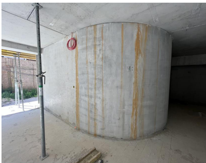
Rys. 6. Półokrągły element prefabrykowany.
