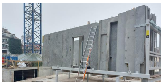
Rys. 2. Ściana prefabrykowana składowana na budowie na specjalnym stelażu.
