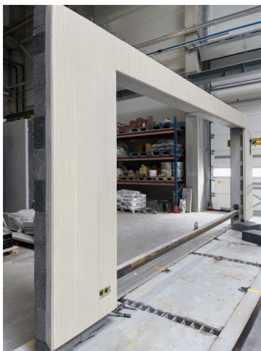
Rys. 1. Ściana prefabrykowana przygotowywana w hali produkcyjnej.
